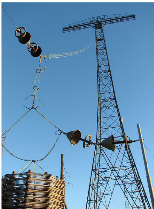
Figur 8.14: Grimetons långvågssändare. En av vertikalerna med sin väldiga avslutningsspole. Bild: Wikipedia, Rolf Broberg Eget arbete
