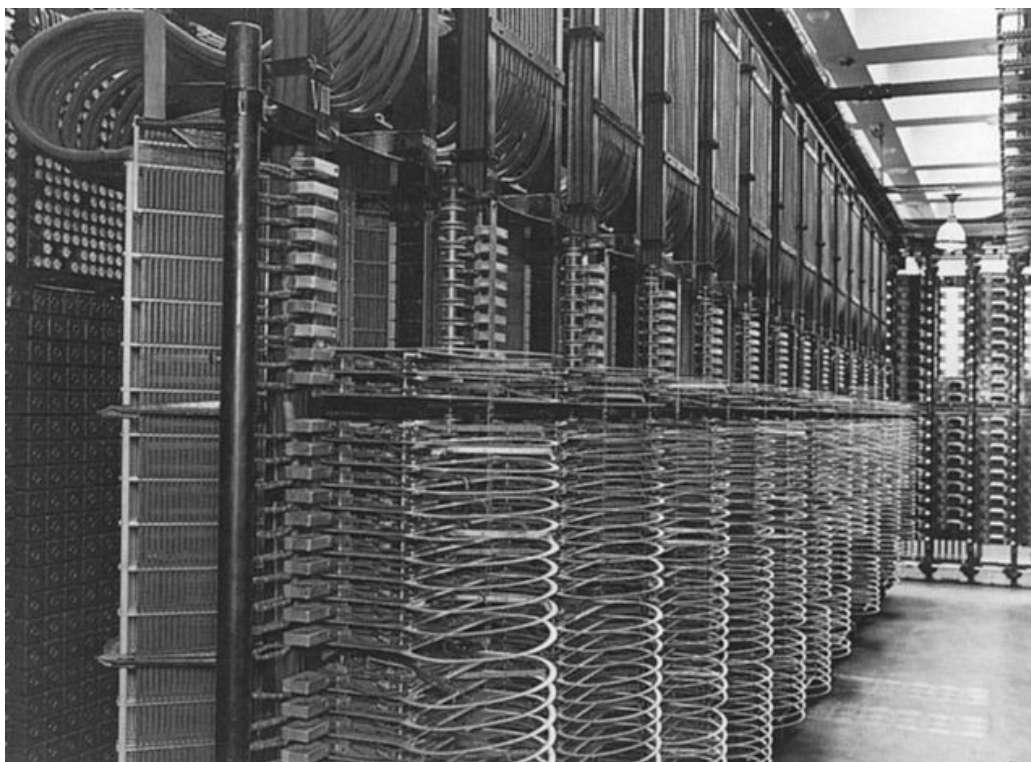
Figur 4.2: Koordinatväljare. Högmodern 50-talsteknik för att koppla samtalen i en storstad. En stor hall var fylld av sådana maskiner när armar av metall vreds och sträcktes ut, efter signalerna som kom från den snurrande petmojen på telefonen. Allt var mekanik, driven av elektromagneter.
