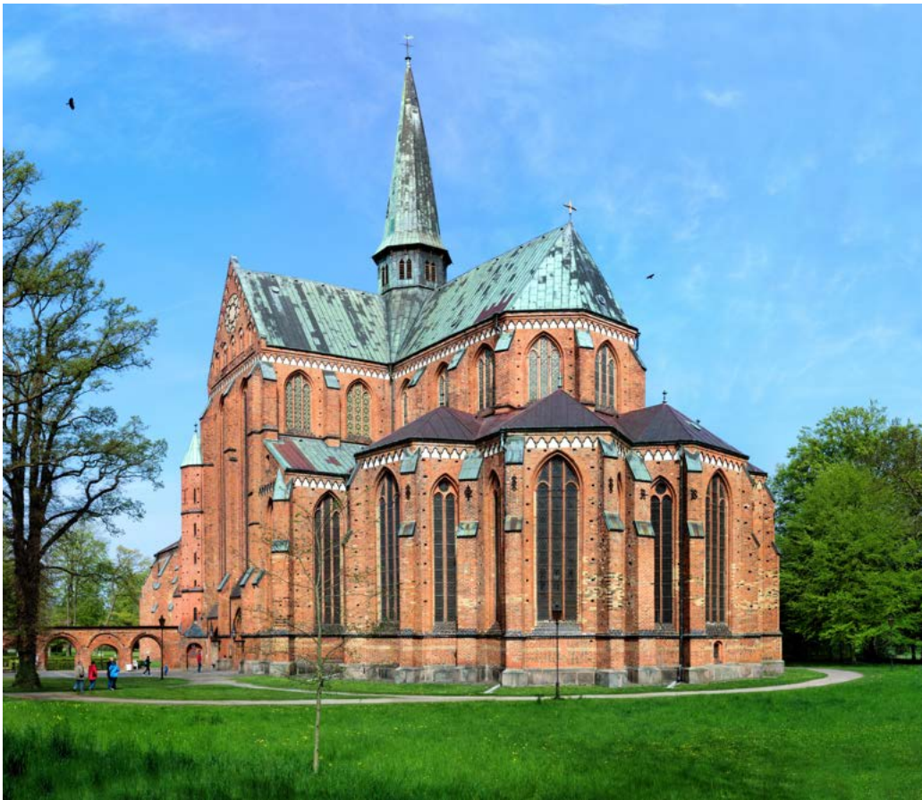
Figur 6.5: Bad Doberans klosterkyrka, oskadad av kriget, ligger ett par mil väster om Rostock. Vad kunde vara mer oskyldigt än att se en berömd sevärdhet? Jag var där ett par gånger. Trakten var öde och man kunde gå i skogen. Där fanns inga mikrofoner. Där fick jag höra de mest upprörande historierna.
