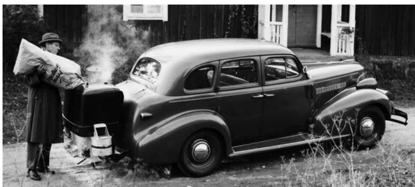
Figur 2.3: Gengasdriven bil. Kol fylls på i det rykande gengasaggregatet där bak. Bild: http://www.ok.se/historia/agerande-i-kristider/gengas-alternativet-under-kriget .
